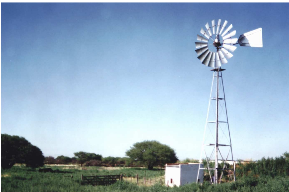
Windmühlen, dienen als Wasserpumpen. Mit Strom Möglichkeit auf Elektropumpen
