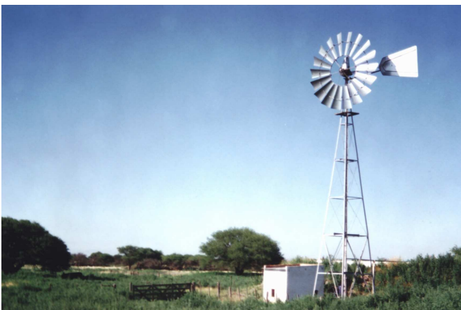
Molino “a viento” para extracción de agua subterránea
