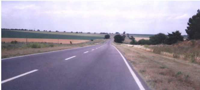
Ruta pavimentada en La Pampa
