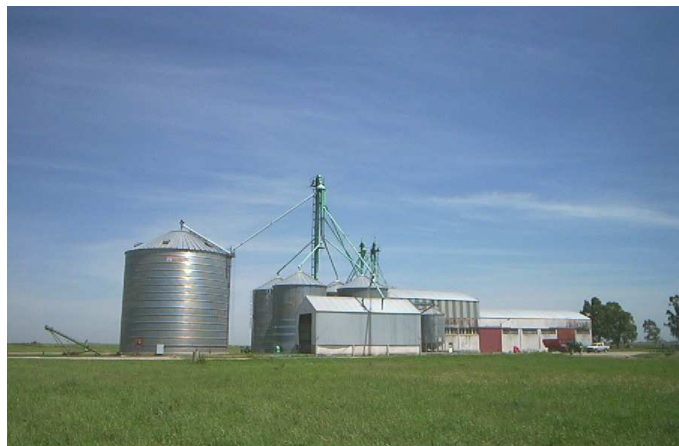
Instalaciones en un Establecimiento de Engorde a Corral
